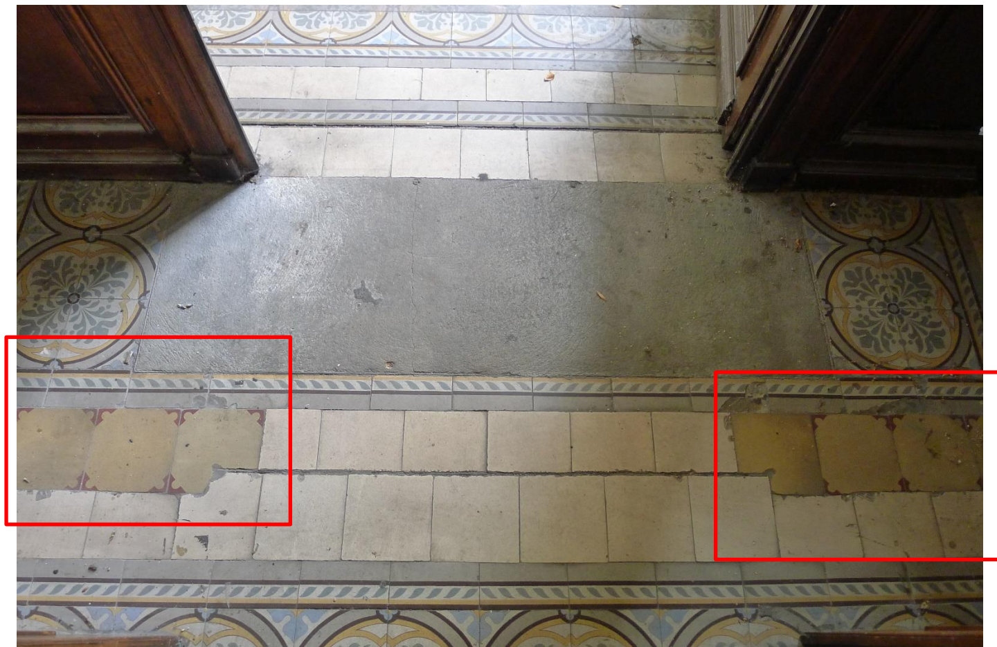
Obr č.11 –1.NP - Původní dlažba u vstupu do budovy lokálně nahrazena dlažbou jiného vzoru
